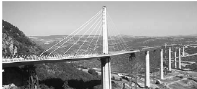
Photo 1 : Viaduc de Millau en cours de construction
