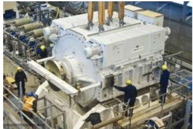
Propulsion intégrée tout-électrique (IFEP) développée par Converteam dotée de deux lignes d'arbres, entraînées chacune par deux moteurs asynchrones d'un poids de 110 tonnes environ !!
